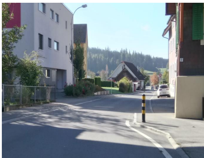
Abbildung 1 Pfosten bei seitlicher Einengung
