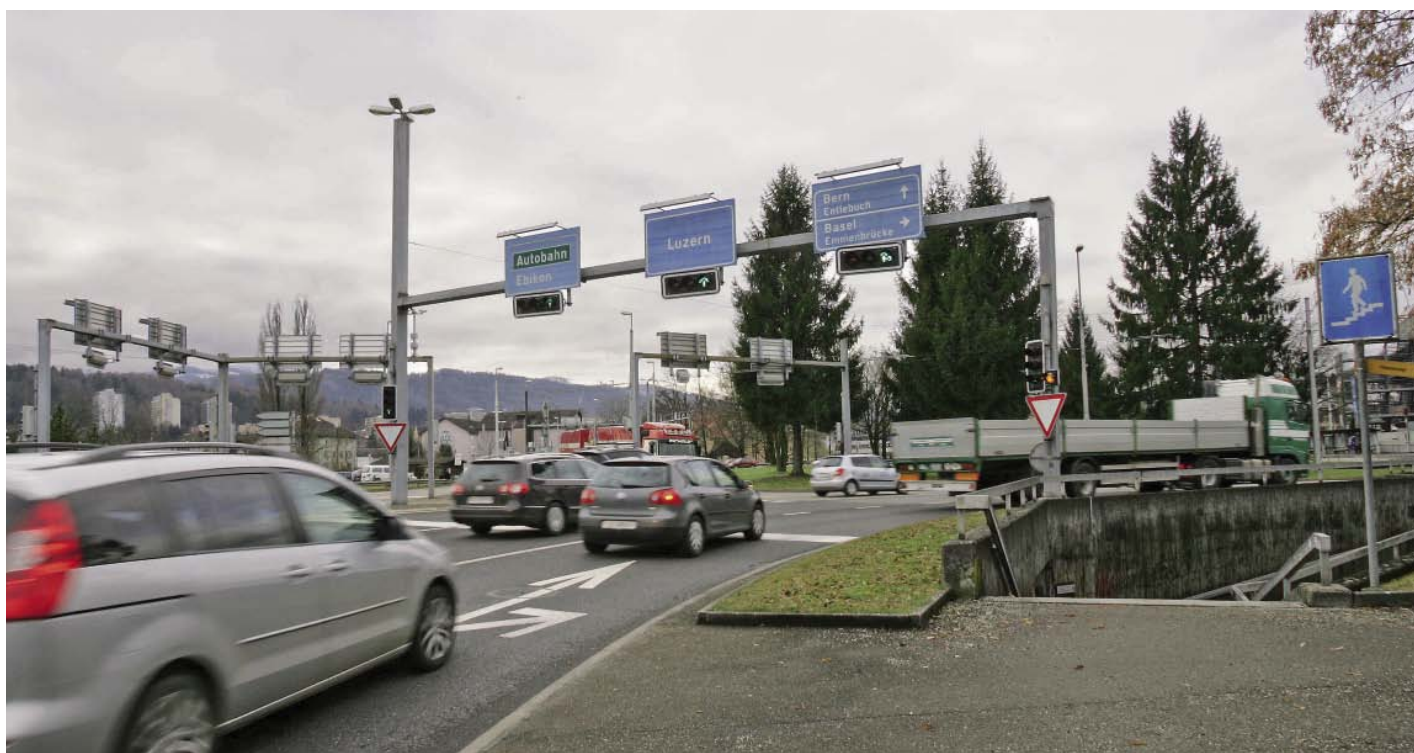
Un Seetalplatz (Lucerna) congestionato che una ristrutturazione completa renderà più funzionale e sicuro.
