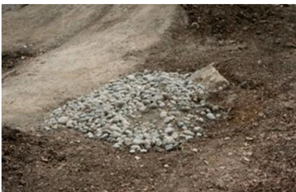
Illustration 4 Drainage dans un lit de graviers
